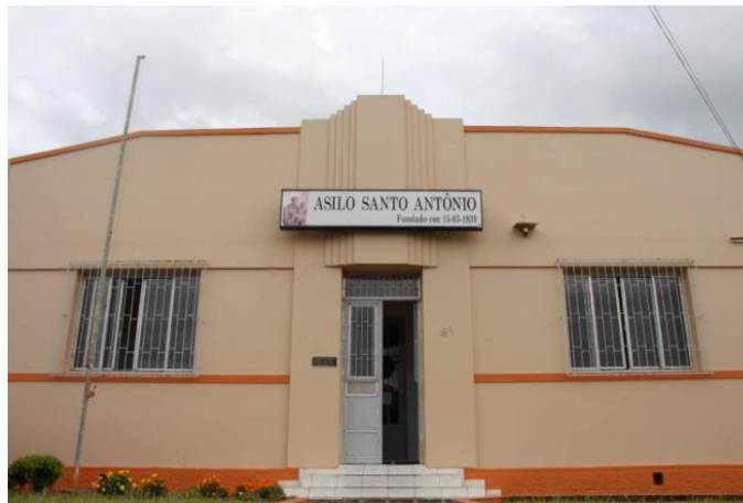
Figura 01 – Fachada da instituição
